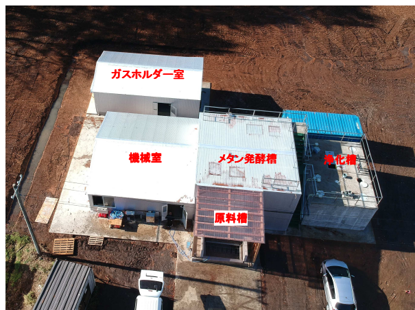
青森東北町発電所の全景
