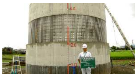
ナガオカスクリーンを用いた浅井戸用の取水装置
