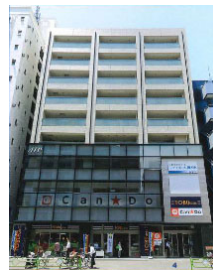
AIP勝どき駅前ビル (2017/12 EXIT)
