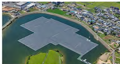
東王田(ひがしおうだ)池ソーラー発電所
