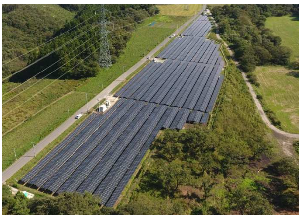
発電所の全景
