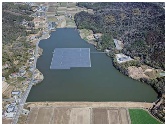
香川県さぬき市 野間池ソーラー発電所
