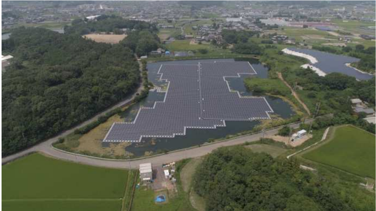
発電所の様子
