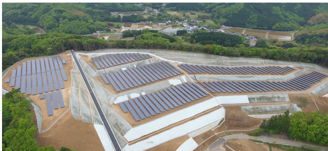
発電所の様子
